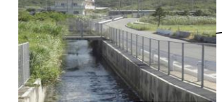
③ 照間の水路 ・フェンス反対側なし ・大雨で鉄砲水あり
